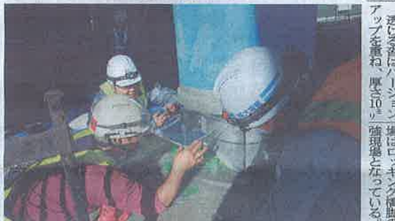
透明型枠の上蓋をセット
