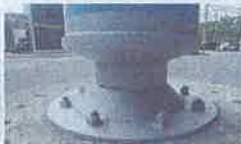
透ける沓施工前のピボット沓
