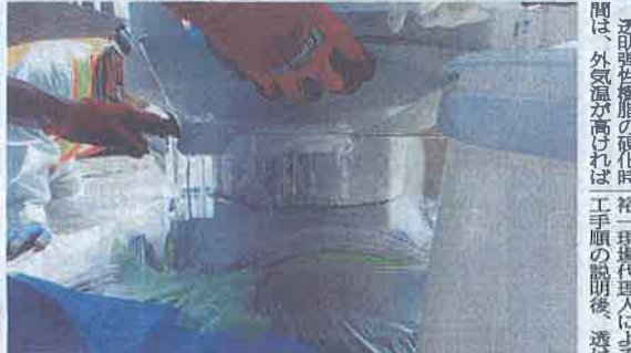
透明弾性樹脂の注入
